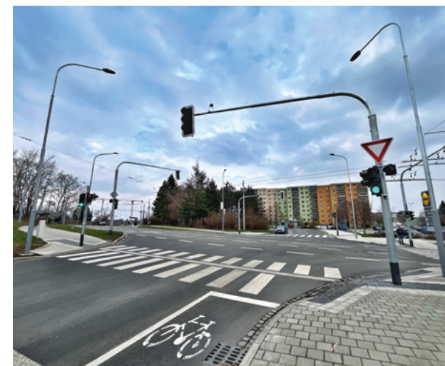
Křižovatka 2.22 Osová – Pod Nemocnicí, výstavba nové světelné signalizace byla součástí projektu Rozvoj ITS v Brně, 1. etapa.
