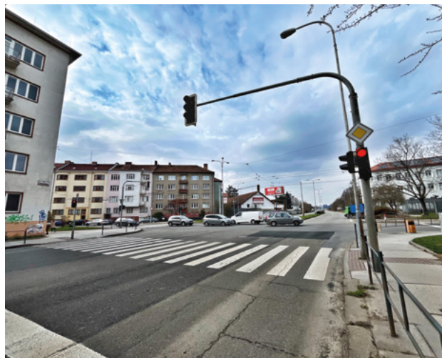
Křižovatka 8.08 Hradecká – Tábor, rekonstrukce světelné signalizace je součástí projektu Rozvoj ITS v Brně, 3. etapa.
