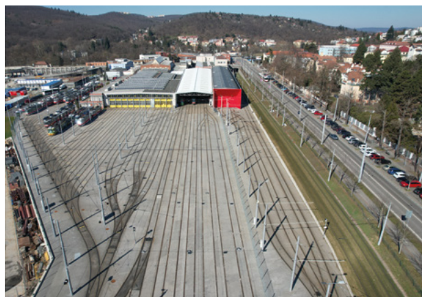
Pohled na rekonstruované kolejíště vozovny.
