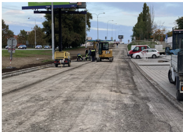
Sportovní – oprava komunikace.
