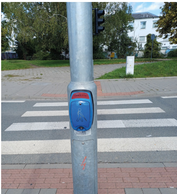
Signalizační akustické zařízení pro nevidomé.
