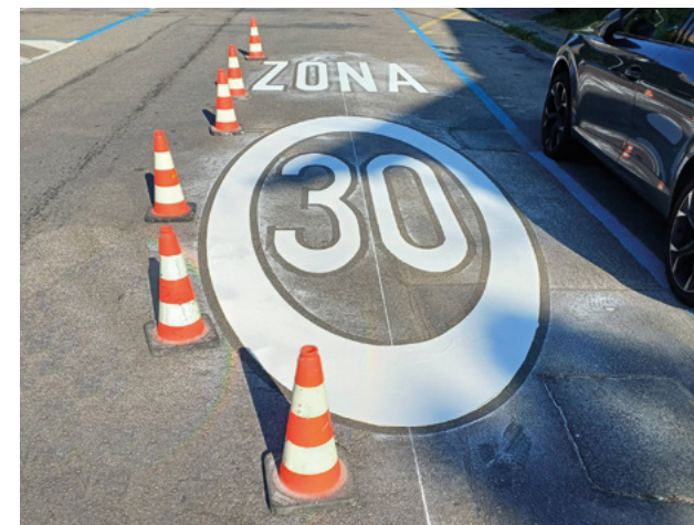
Pokládka VDZ v zóně s omezením rychlosti 30 km/hod.
