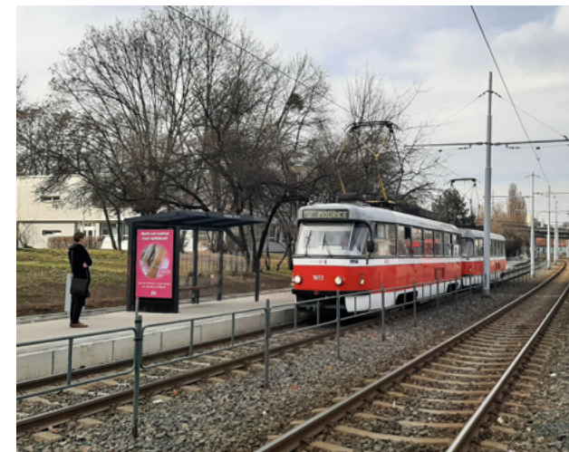
Rekonstrukce nástupiště v zastávce Hluboká.
