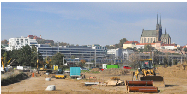
Výstavba prodloužené ulice Uhelná.
