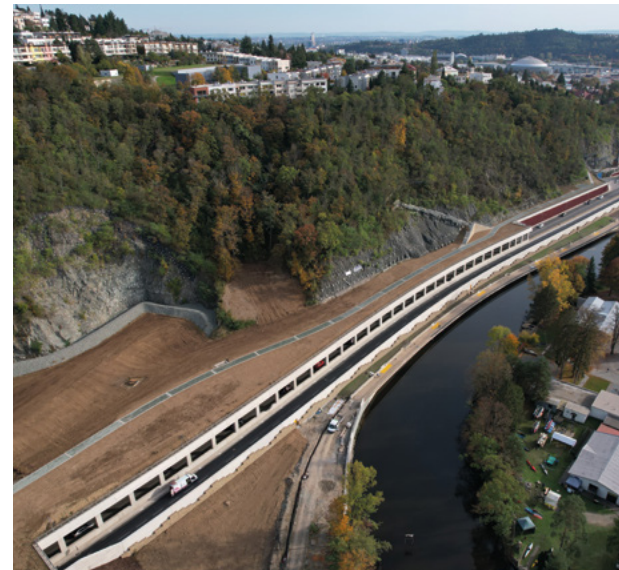
I/42 Brno, VMO Žabovřeská – etapa II.
