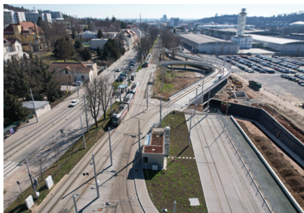
Část východního zhlaví vozovny s novou smyčkou.
