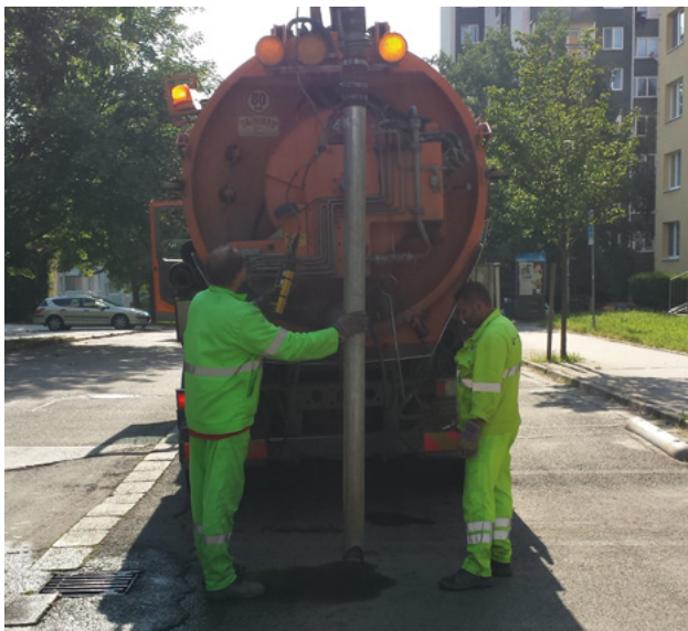
Čištění uličních vpustí.
