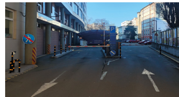
Parkovací dům IBC Příkop.
