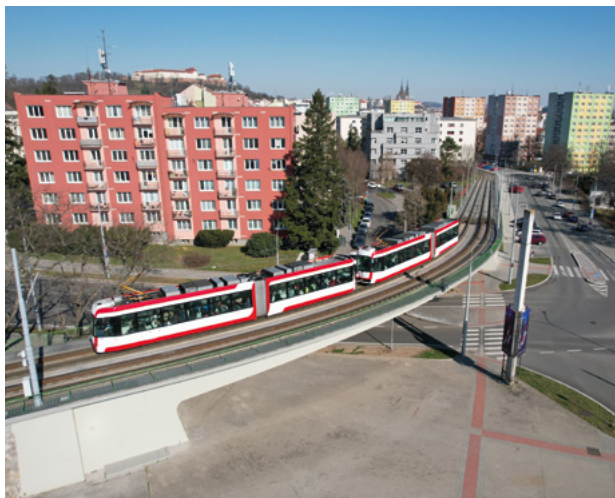
Tramvajový most u výstaviště.
