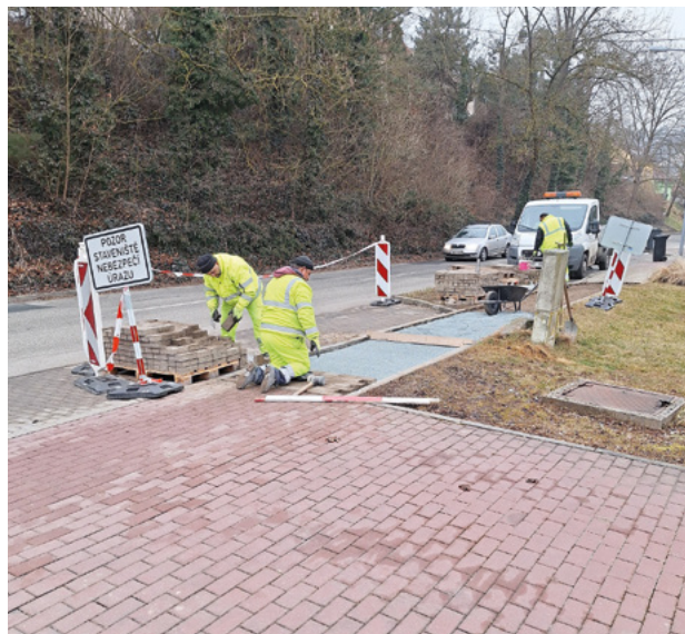
Ruční pokládka zámkové dlažby.
