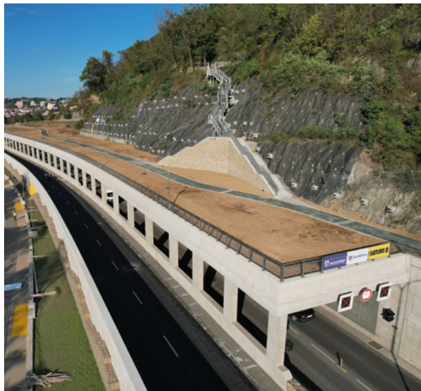
I/42 Brno, VMO Žabovřeská – etapa II.
