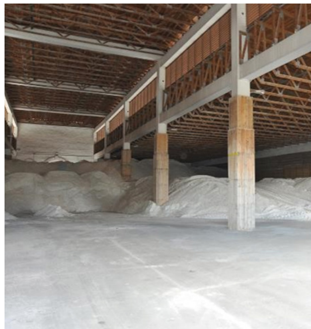
Solná hala se zásobami technické soli.
