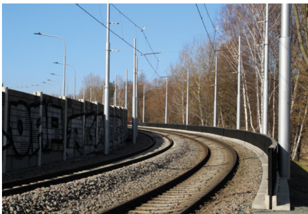
Modernizovaný úsek Obvodová s protihlukovou clonou.
