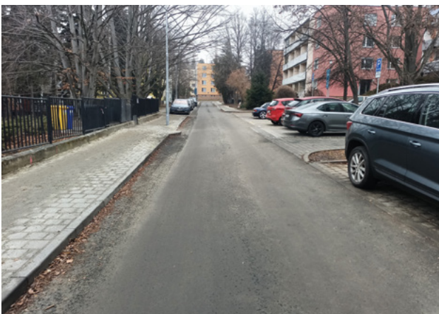
Plovdivská – rekonstrukce komunikace.
