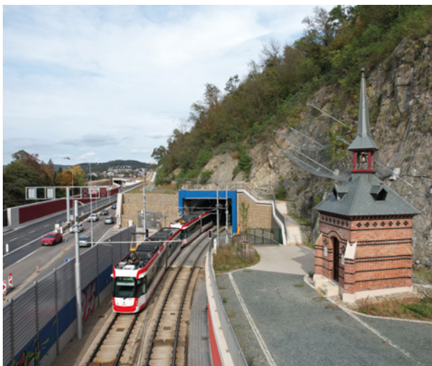
Souprava EVO2 u jižního portálu tunelu Žabovřeská.
