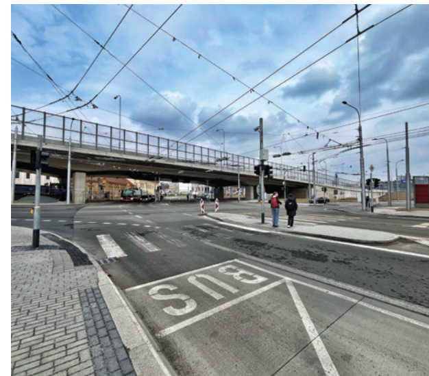
Křižovatka 5.05 Tomkovo náměstí – Dukelská, rekonstrukce světelné signalizace je součástí projektu Rozvoj ITS v Brně, 2. etapa.
