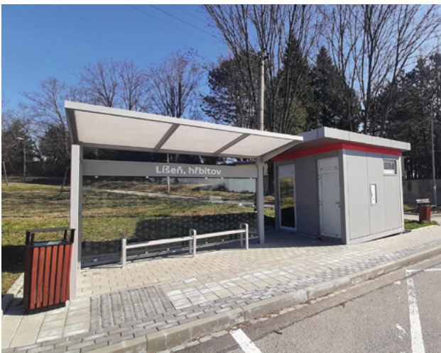
Přístřešek a provozní objekt ve smyčce Líšeň, hřbitov.
