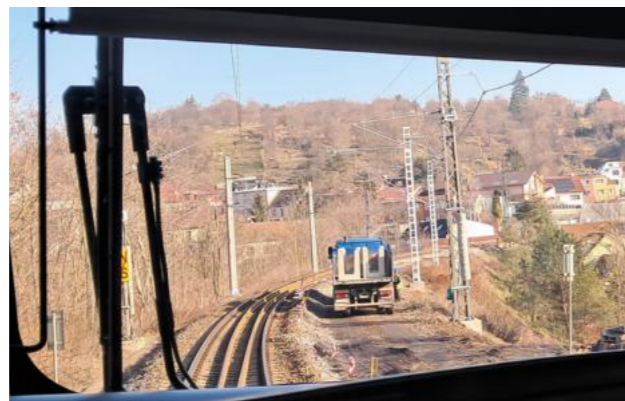
Pohled ze stanoviště strojevedoucího na rozestavěný traťový úsek Brno-Lesná - Brno-Maloměřice.
