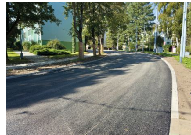
Řezáčova – oprava komunikace a chodníků.
