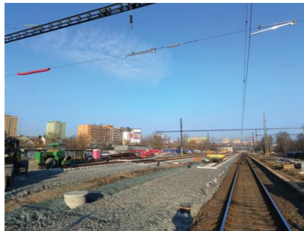
Pokládka nových kolejí ve stanici Brno-Královo Pole.
