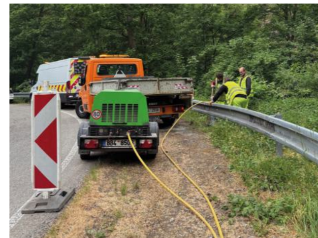
Výměna bezpečnostního prvku - svodidla.
