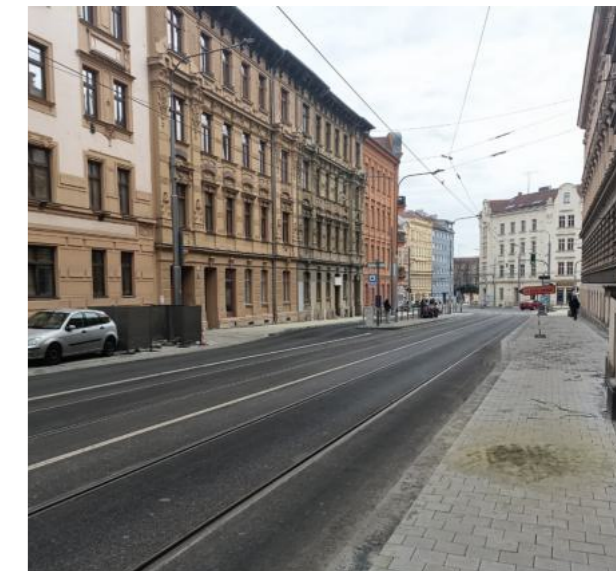
Rekonstrukce Údolní – od Husovy po Úvoz.
