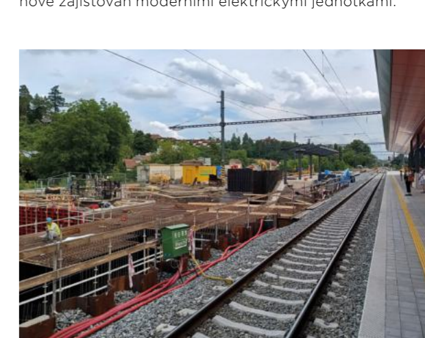
Část nástupiště č. 3 a podchod před betonáží.
