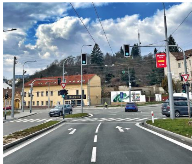
Křižovatka 5.22 Cacovická – Tomkovo náměstí, rekonstrukce světelné signalizace je součástí projektu Rozvoj ITS v Brně, 2. etapa.
