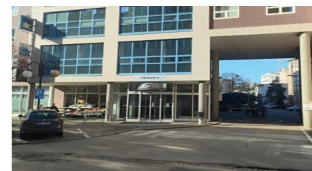
Parkovací dům IBC Příkop.
