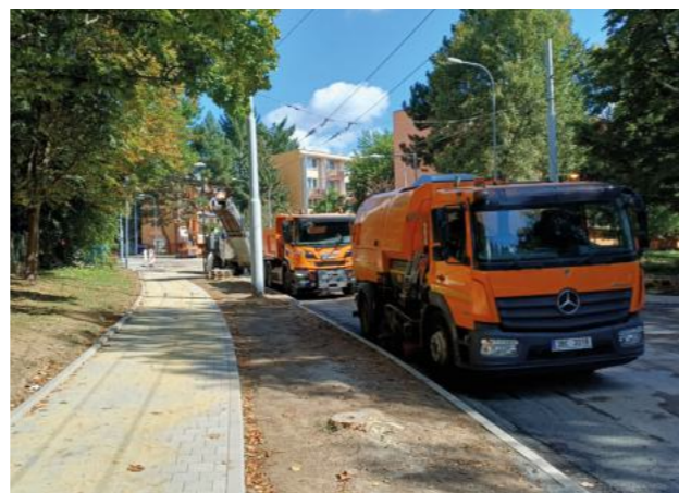
Souvislá údržba komunikace na ulici Řezáčova.
