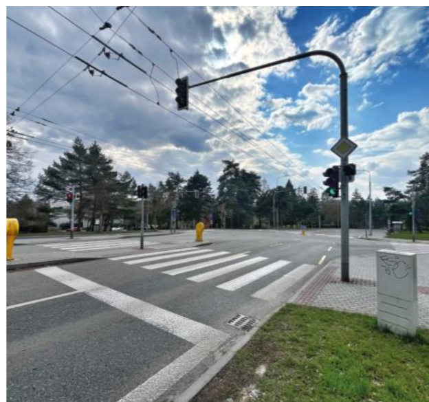
Křižovatka 8.22 Technická – Královopolská, rekonstrukce světelné signalizace je součástí projektu Rozvoj ITS v Brně, 3. etapa.
