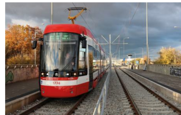
Modernizace TT Vídeňská, úsek Bohunická – Moravanské Lány – smyčka Modřice.
