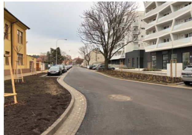
Řezáčova – oprava komunikace a chodníků.
