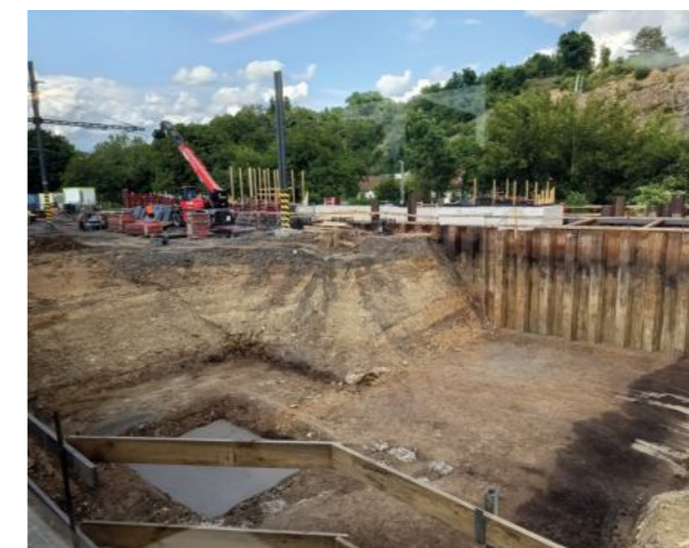
Stavební jáma budoucího podchodu a schodiště k nástupišti č. 3.
