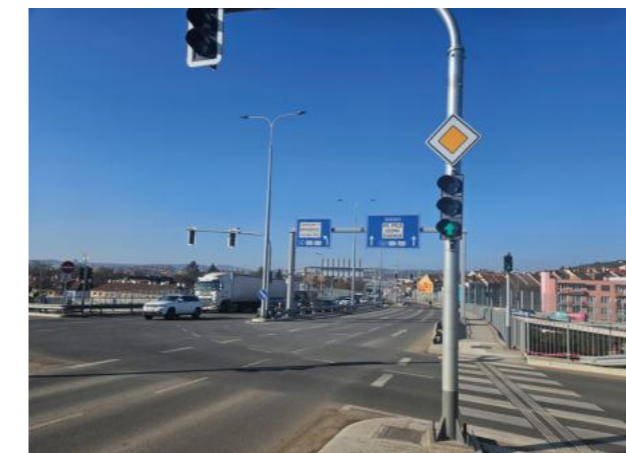
Rekonstruovaná křižovatka se SSZ Ostravská – Otakara Ševčíka.
