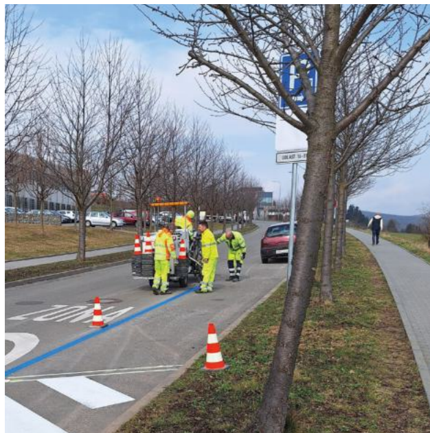
Strojní pokládka VDZ - „modrá zóna“.
