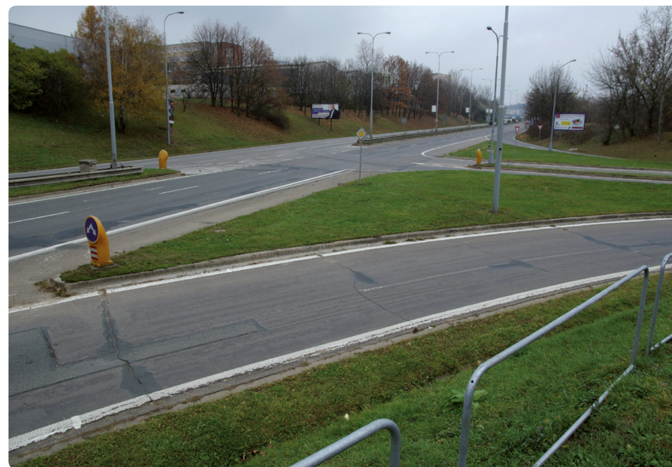
Foto: křižovatka Hradecká – rampa Hradecká.
