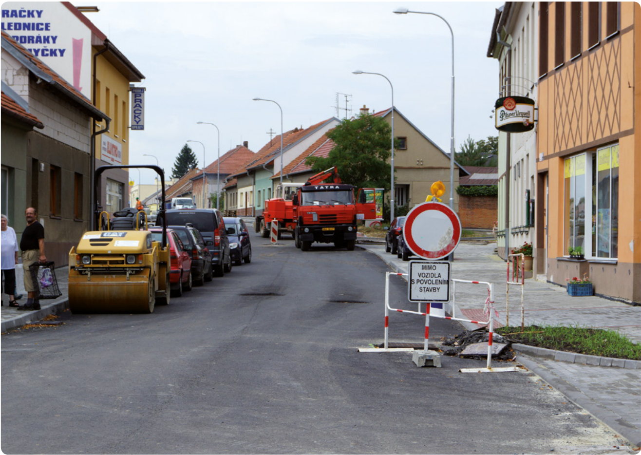
Foto: rekonstrukce komunikace Tuřany.
