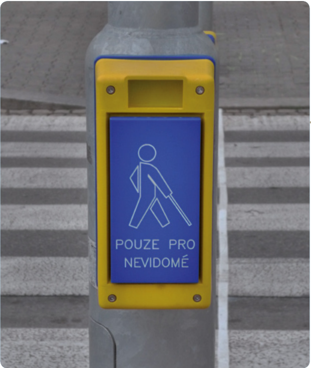
Foto: akustická signalizace pro nevidomé.
