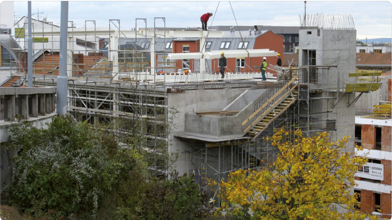
Foto: stavba parkovacího domu na ulici Kopečná.
