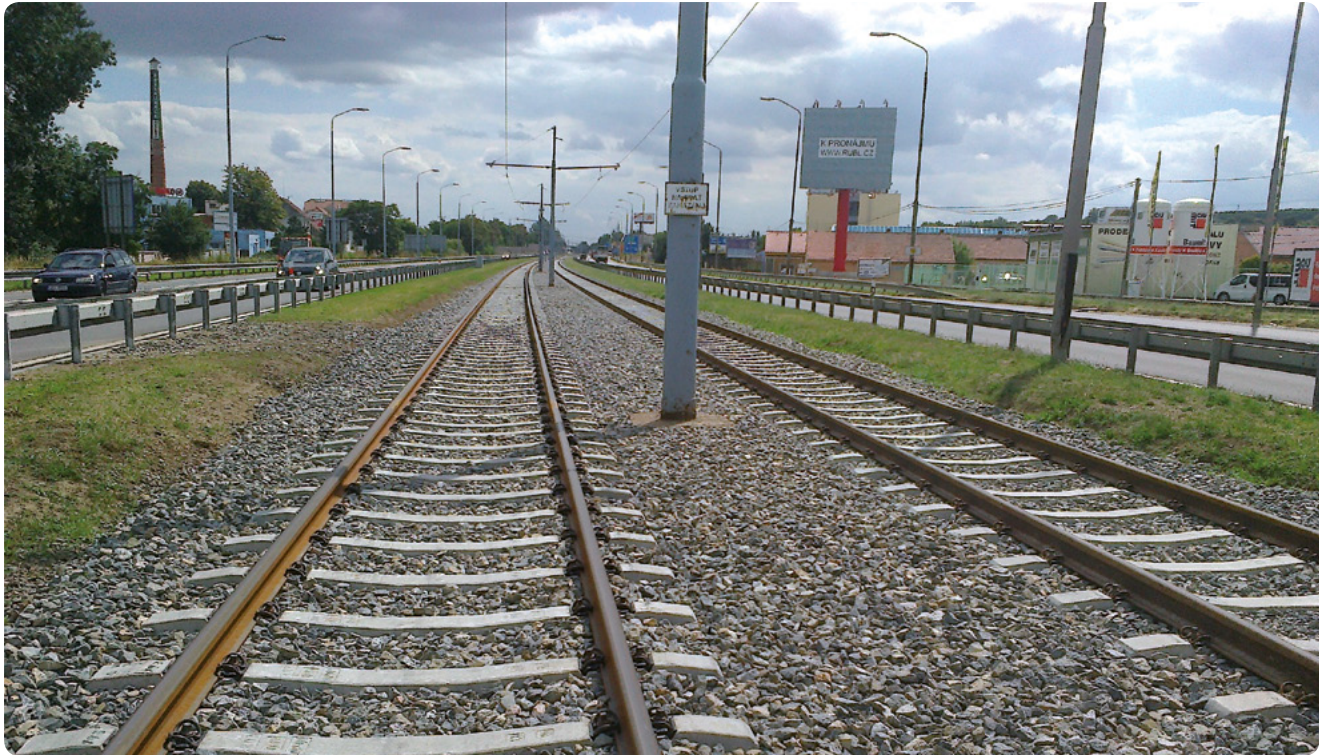
Foto: tramvajová trať v ulici Vídeňská (Modřice) po rekonstrukci.
