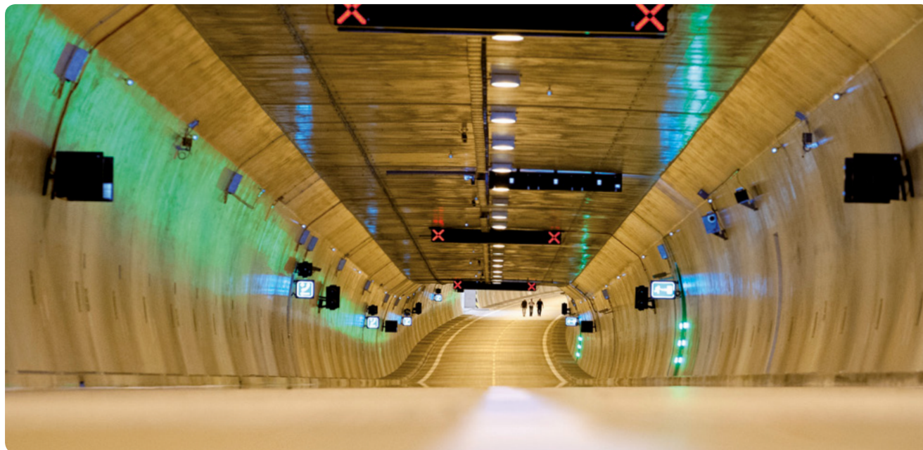
Foto: Dobrovského tunely.
