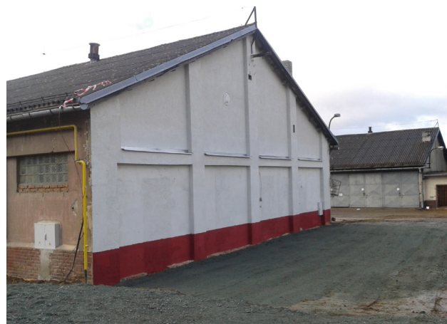
Demolice budov areálu židenických kasáren.
