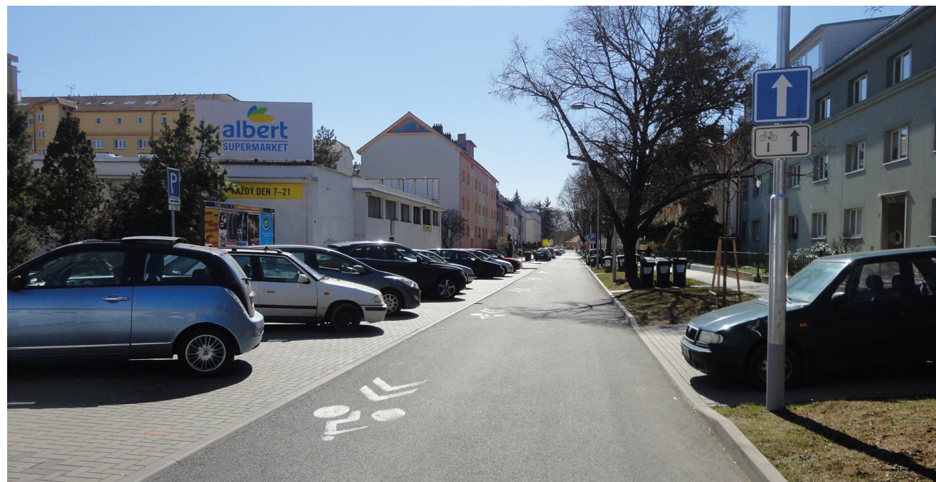
Ulice Cornovova po opravě.
