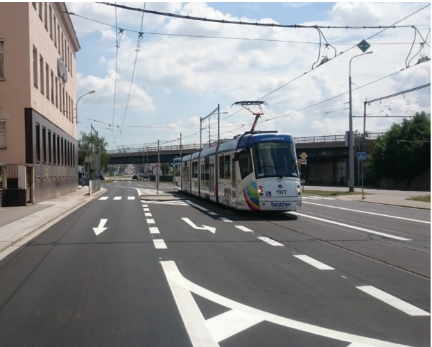
Tramvajová trať v ul. Olomoucké,
