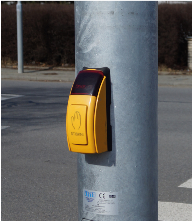
Akustická signalizace pro nevidomé.
