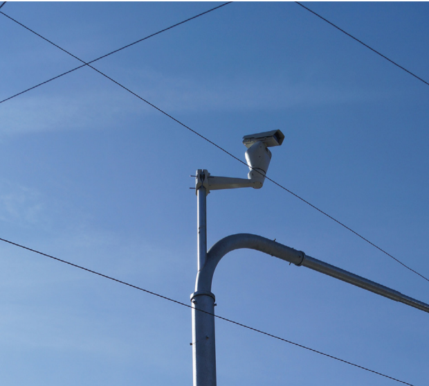
Nově osazený kamerový dohled na křižovatce SSZ Svatoplukova-Rokytova.
