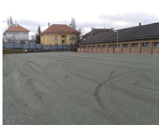
Demolice budov areálu židenických kasáren.
