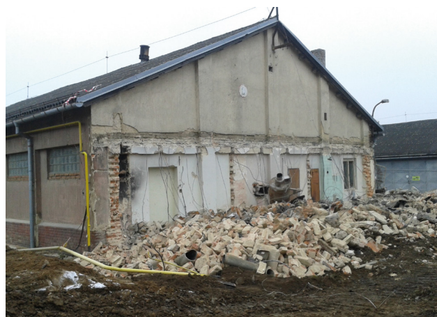
Demolice budov areálu židenických kasáren.
