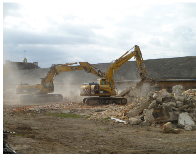
Demolice budov areálu židenických kasáren.
