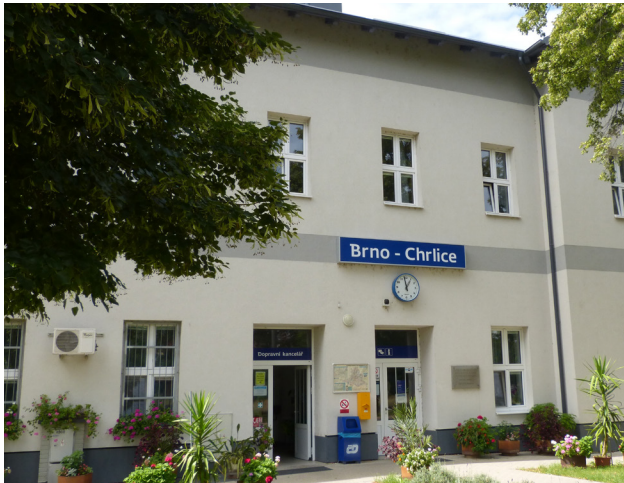
Nádražní budova Brno-Chrlice.
