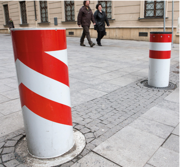
Ukázka profilu zádržného systému na ulici Běhounská.
