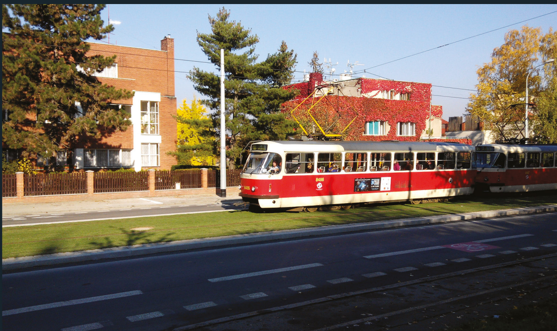
Rekonstrukce tramvajové trati ve Střešovické ul. v Praze
